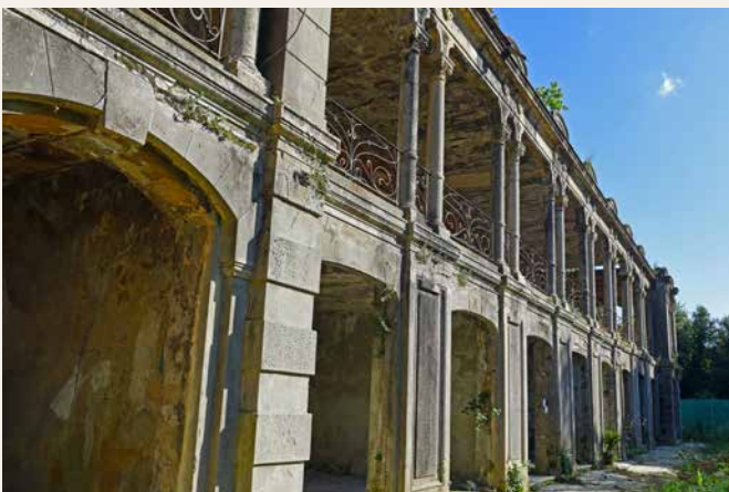
Fig.32 – loggia terrazza con negozi sottostanti
