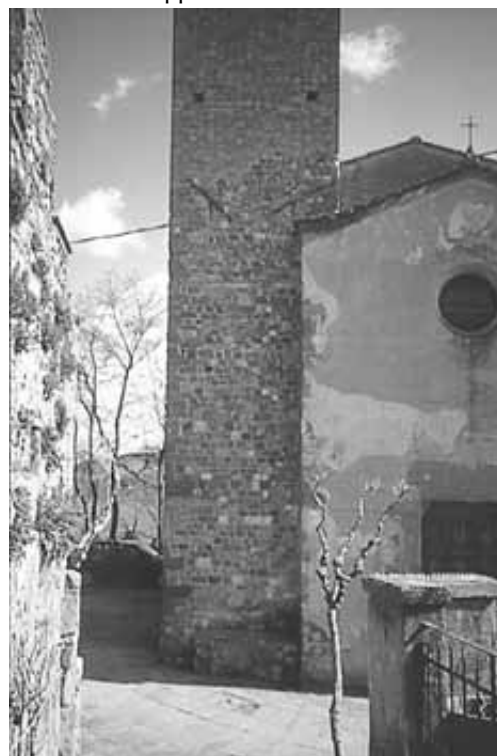
Chiesa di S. Stefano a Capraia Fiorentina: vista della torre. (foto dell'autore)
